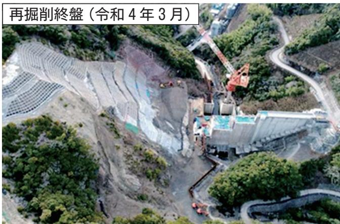
節理面対策である左岸再掘削工は、令和4年7月に完了し、準備期間を経て、同年9月より左岸堤体コンクリートの打設を再開しました。
