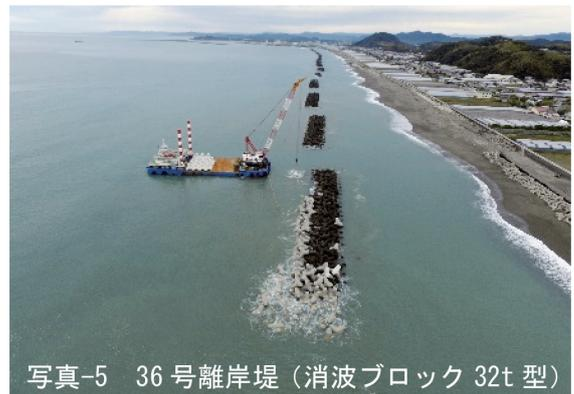
写真-5 36号離岸堤 (消波ブロック 32t 型)
