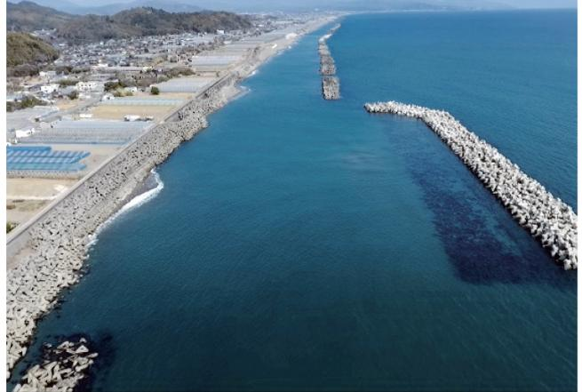
写真-7 離岸堤整備完成状況（53号離岸堤から東方向を望む）
