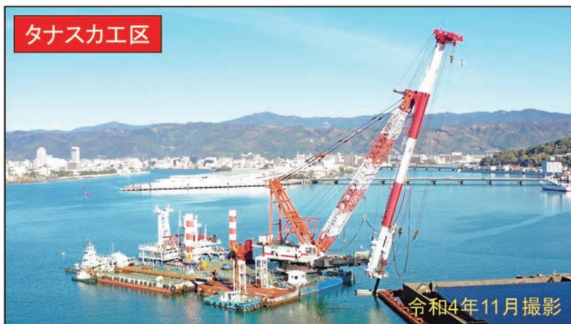
図-5 各工区進捗状況
