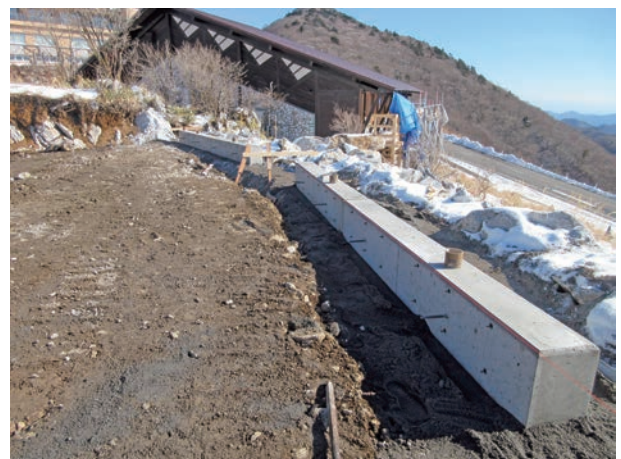
写真-10 雪解け後での基礎設置
