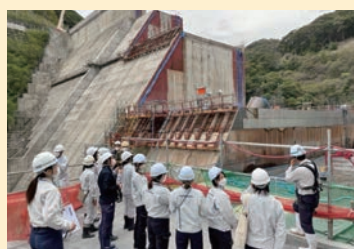
和食ダム 現場視察・勉強会 10月12日
