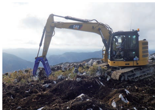
写真-7 レンチャーヘッドでの作業
