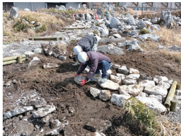
写真-6 石張り状況
