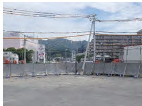
防音シート設置
