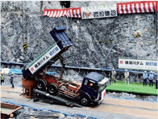
写真-3 ダム本体コンクリート初打設
