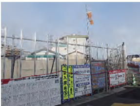
透明仮囲いパネル設置
