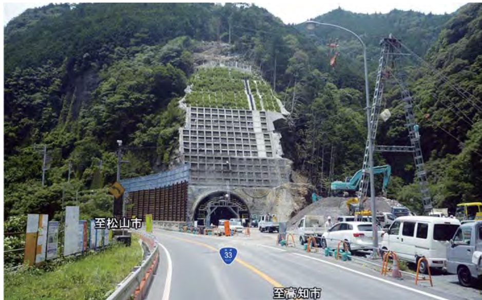
写真-3 橋地区：高知側坑口（令和元年7月撮影）
