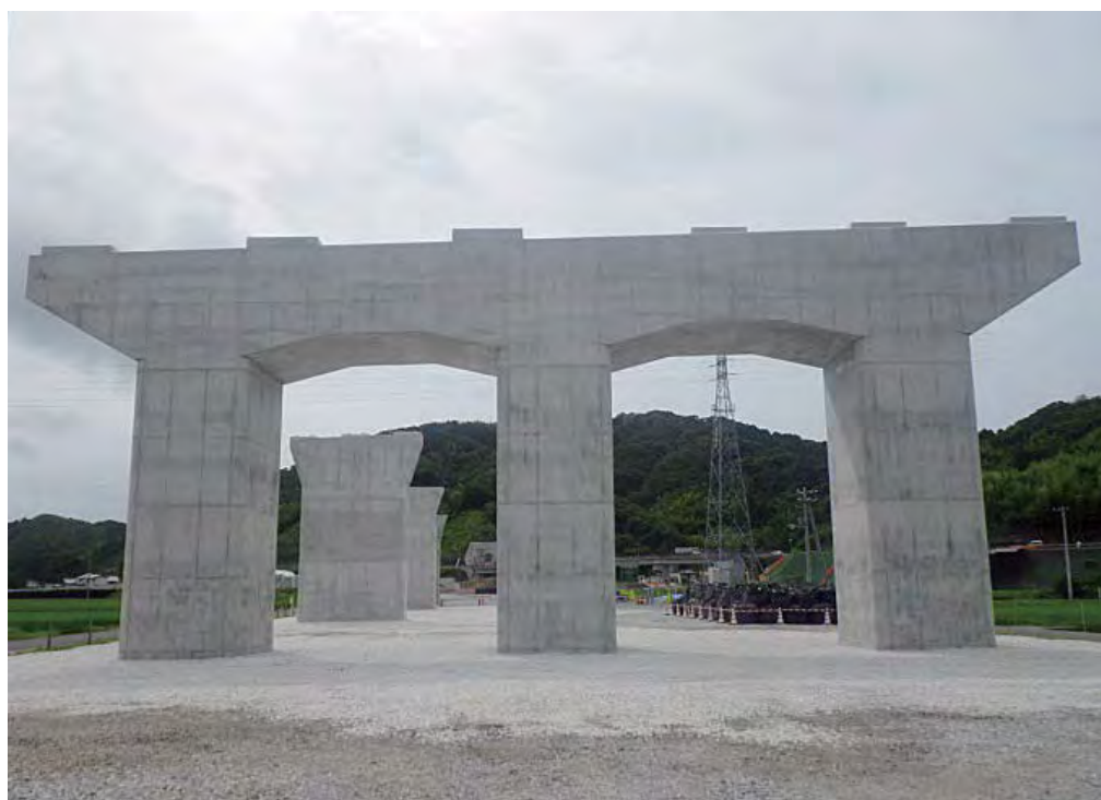
写真－ 1 五台山第 4 高架橋 (平成 30 年)
