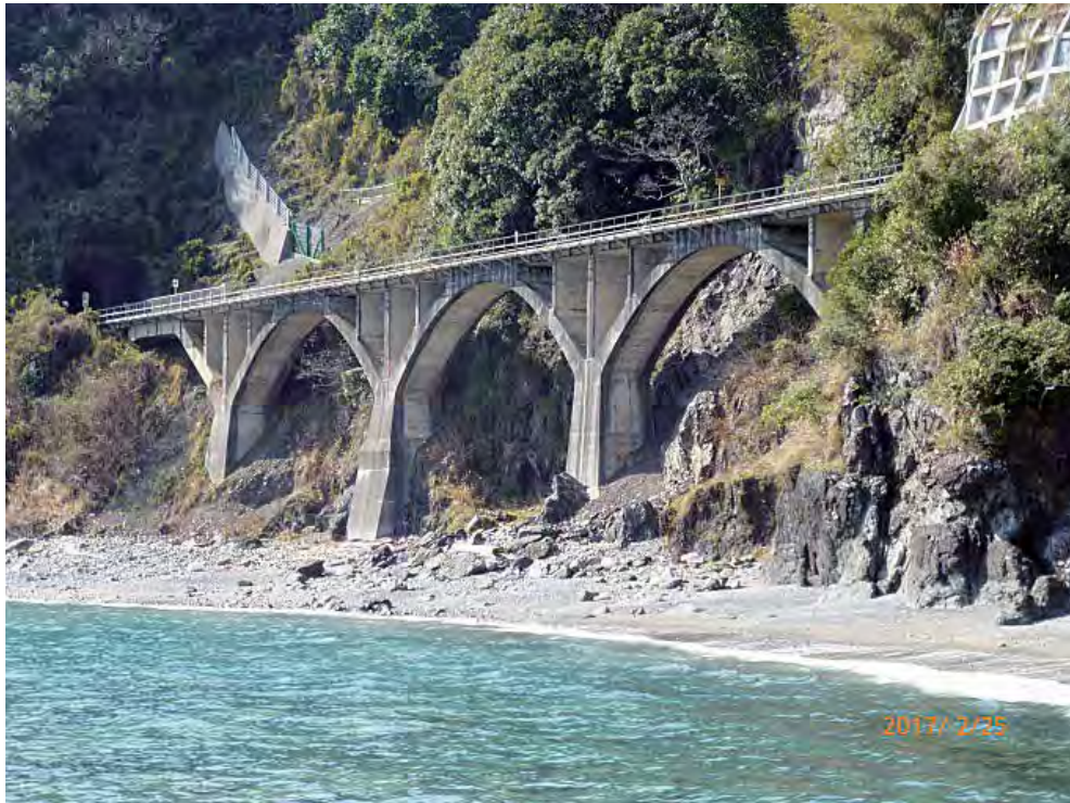
写真－2 領地第2橋梁(昭和13年)
