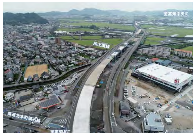
写真-2 鵜野・一宮地区施工状況（令和元年7月撮影）
