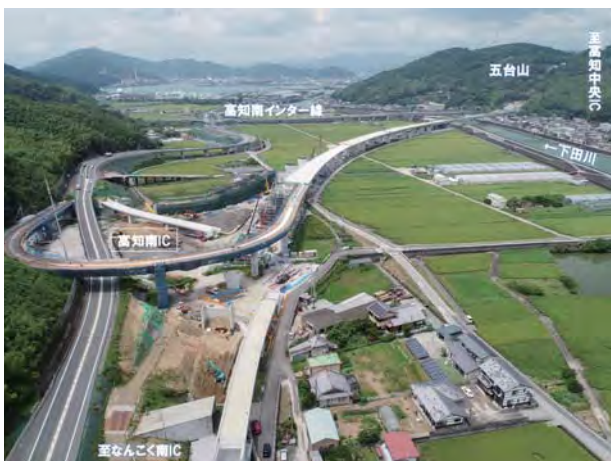
写真-1 五台山地区施工状況（令和元年7月撮影）
