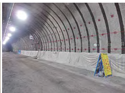
写-17 ロックボルトライン
