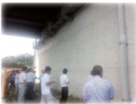
嘉川IC高架橋【橋台】 （平成19年建設：システム試行段階）
