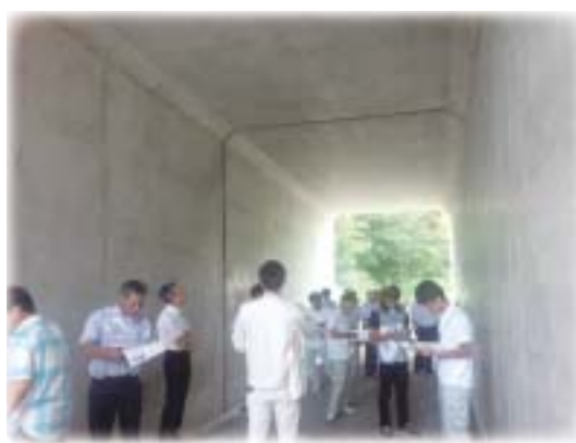
由良ICボックスカルバート （平成26年建設：システム導入後）
