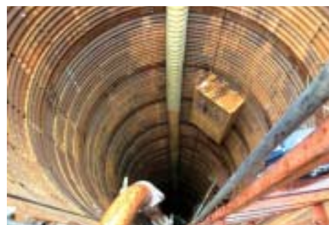
深礎杭の施工状況
