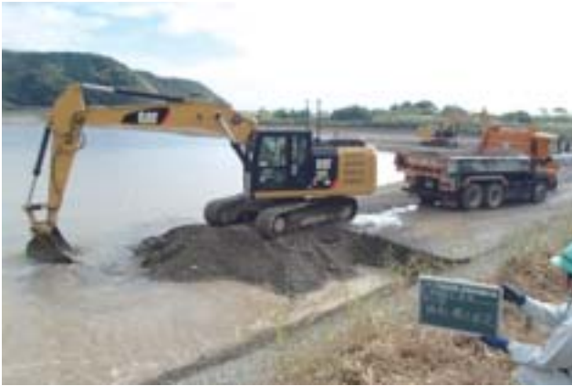
写真-8 MGバックホウによる水中掘削状況
