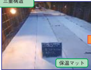
保温養生 三重構造
