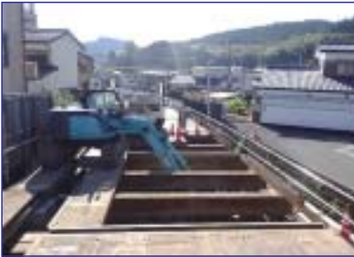
仮設架台掘削状況
