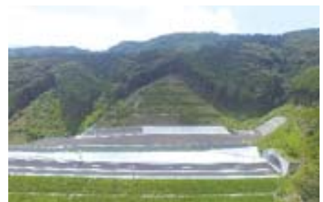
写真-3 ドローン撮影による完成写真
