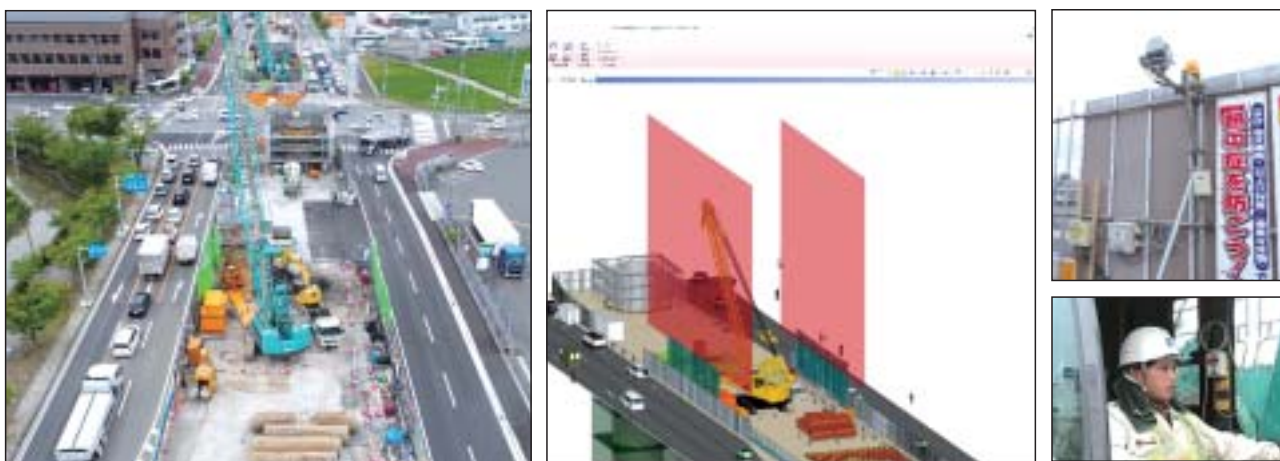
写真-19 レーザースキャナーによる危険エリアへの侵入防止対策
