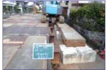
仮設架台設置状況
