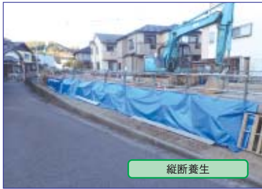
保温養生 三重構造
