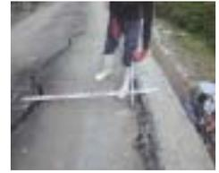
対策-1 路側ブロック法面変状を抑制するため、路側ブロック法面に「鉄筋挿入工」を実施しました。
