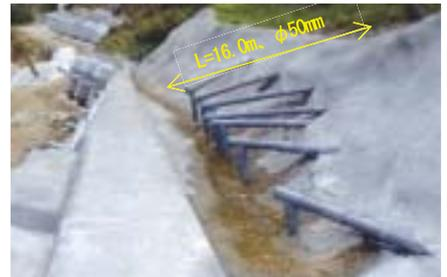
対策-2 アンカー背面形状を確保するため、「背面調整コンクリート」をモルタル吹付により実施。
