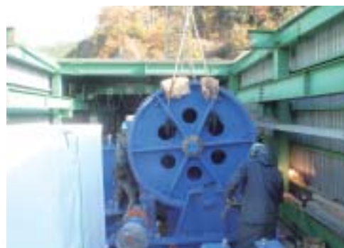
図-4 2号開閉装置組立て
