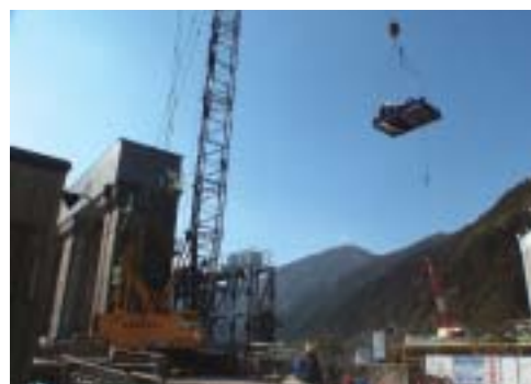
図-2 1号開閉装置吊り込
