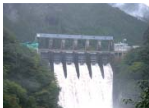
図-3 放流時の長安口ダム
