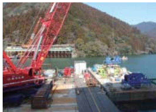
図-1 6号開閉装置吊り込
