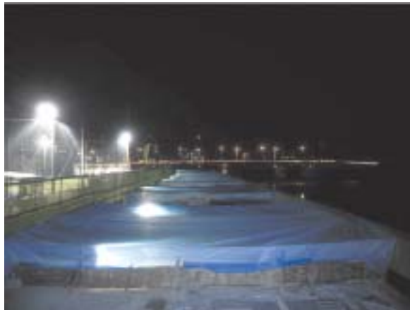
写真-4 保温養生 (工事区域全体)
