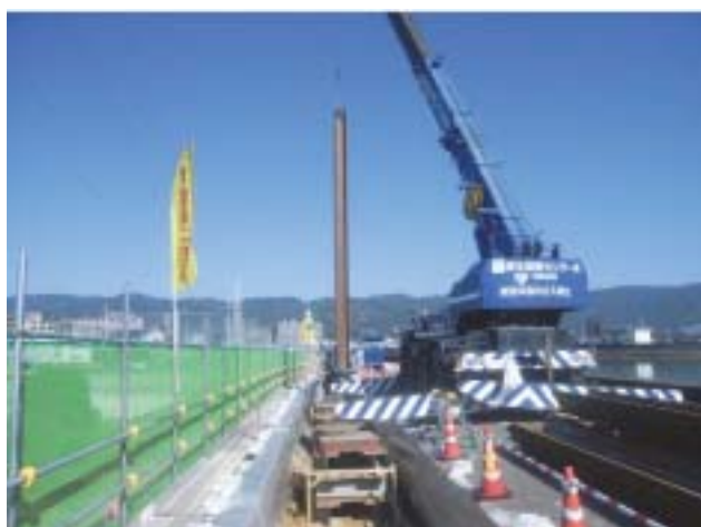
写真-2 施工状況（作業架台設置）
