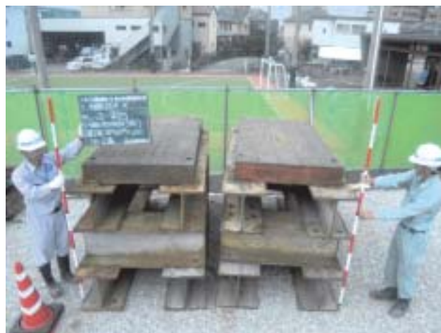
写真-3 作業架台（2基）
