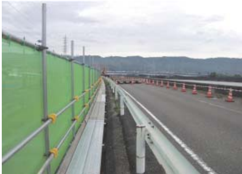
写真－1 防護施設を兼用した安全通路
