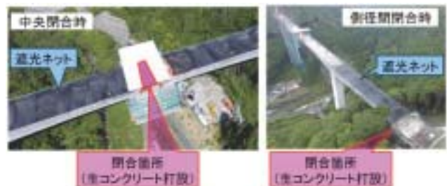
写真一 遮光ネットによる日照の遮断
