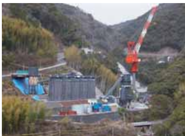
写真4 施工設備配置状況
