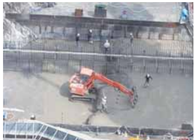
写真6 バイバックによる締め固め状況
