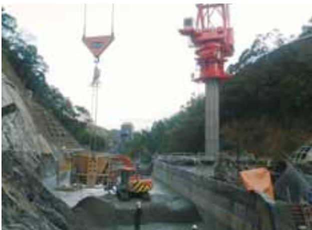
写真5 コンクリート打設状況
