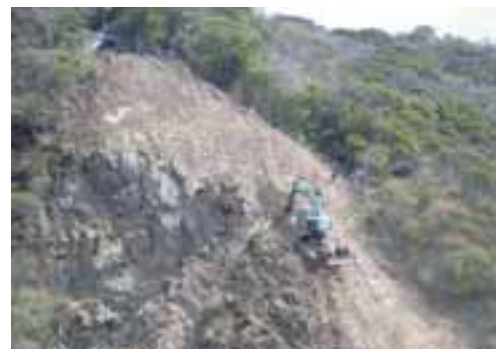
写真2 左岸掘削状況 (H26.4月)
