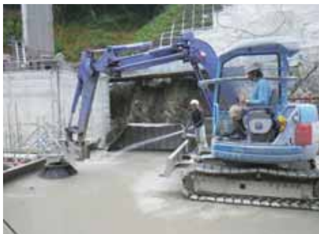
写真7 グリーンカット状況
