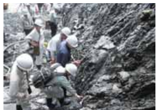
写真3 ダム基礎地盤検査の実施状況
