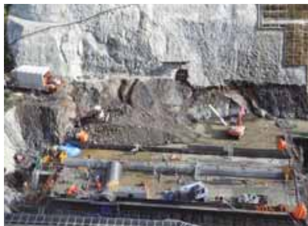
写真8 堤内仮排水路等の施工状況
