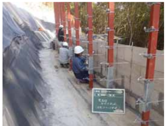
写真 - 4 壁面材施工状況
