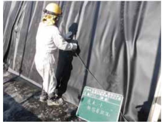
写真 - 3 シート溶着状況
