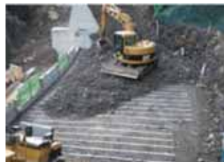
図 - 4 補強土壁工法
