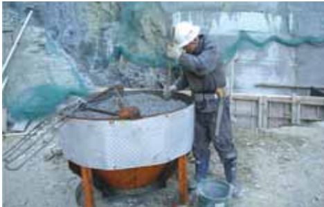
温度測定用コンクリート採取状況
