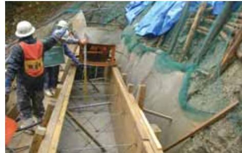
コンクリート打設状況
