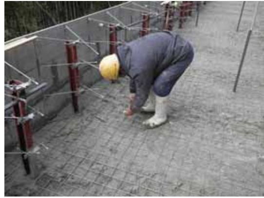
写真 - 7 補強金網設置状況
