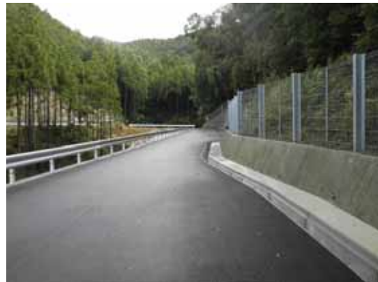
写真 - 9 完成した付替市道
