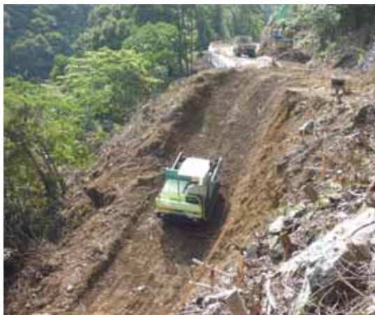
写真 - 1 不整地運搬車による搬出状況
