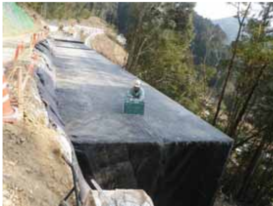
写真 - 8 遮水シート敷設状況
