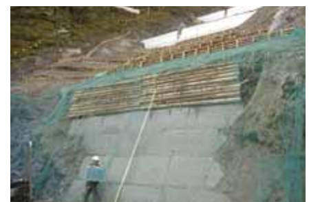
仮設土留コンクリート設置完了
