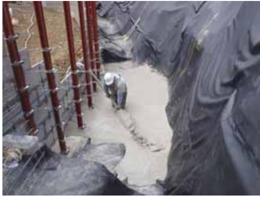
写真 - 6 気泡混合軽量土打設状況
