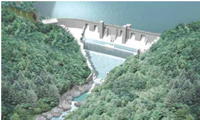
全国初の「側水路減勢方式」を採用した横瀬川ダム完成予想図
