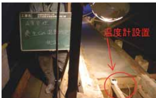
夜間温度測定状況
