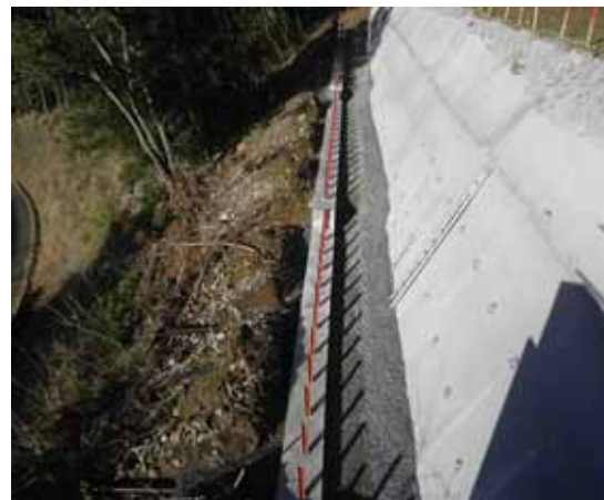
写真 - 2 基礎コンクリート施工状況
