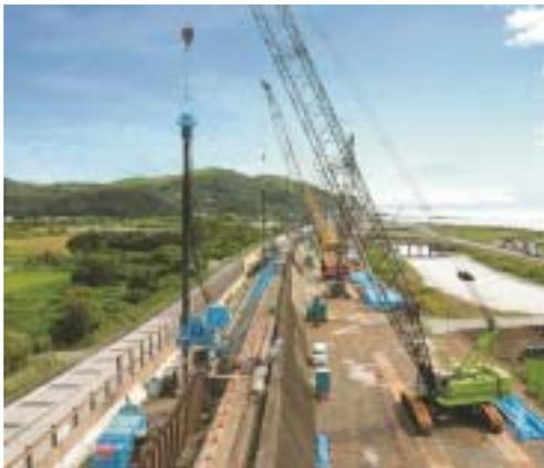
写真-4 矢板打設状況 (近景)
