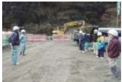
打設前の確認(作業従事者)
