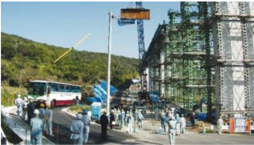
鋼桁架設中の状況を熱心に見学
