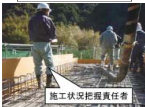
施工状況の監視状況
