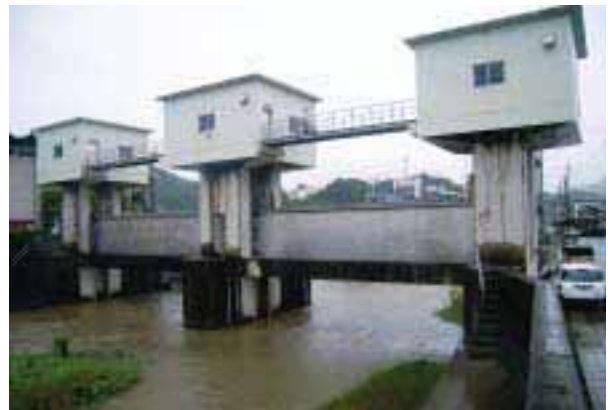
写真 3 須崎港・大間津波水門
