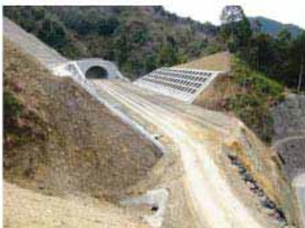
現場状況写真 (近景)
