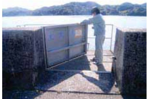
写真5 スイングゲート
