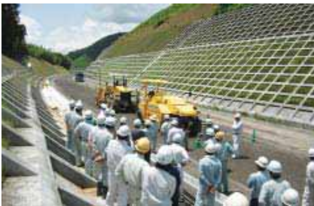
写真 - 4 舗装工 (路盤工) の情報化施工の説明に熱心に聞き入る参加者 アンテナを付けたグレーダーでブレード高さ管理、転圧の面管理
