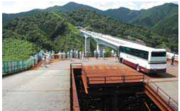
写真-1 久礼坂の現道から下方に見える仮設進入路上から大坂谷橋梁福田監督官の説明を受ける
