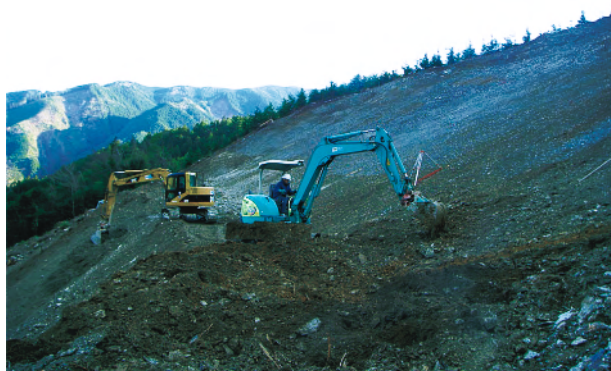
バックホウ ( 0.14\text{m}^3 ) による法切作業 中央はバックホウ ( 0.45\text{m}^3 )
