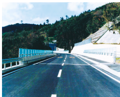
全線開通した佐田岬半島道路
