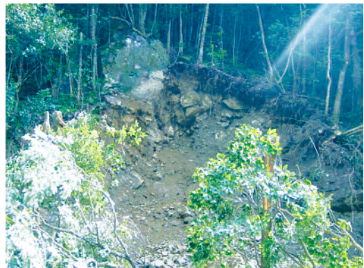
写真 8. 8月17日の放水後の法面、巨石下部が剥き出し、右肩部分の転石が無くなりえぐられたようになっている。また、樹木の根も土のう防護柵の中へ落下したようである。
