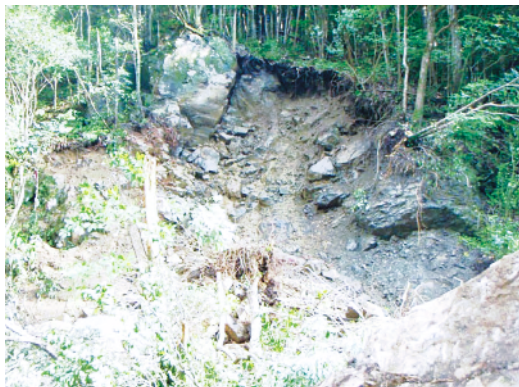
写真 7. 8月17日の放水前で法面の巨石周辺や右肩に転石があり、樹木の根が真ん中に残っている。
