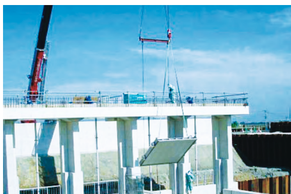
写一(1) クレーンの親子フックを用いた吊込方法
