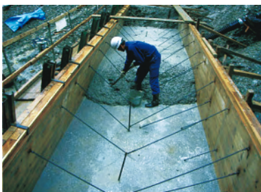
型枠内でのコンクリート採取
