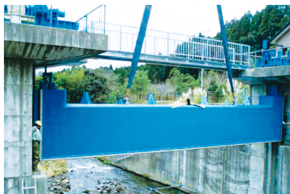
写一(4) 操作台の下からの吊込方法
