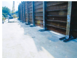
写真19. 流用材料のH鋼100の全景
