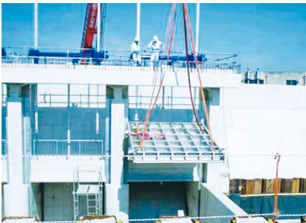
写一(2) 開閉装置を用いた吊込方法
