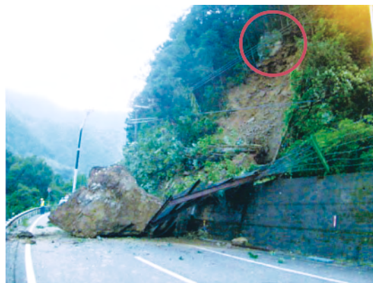
写真5. 崩壊部法面に残った同規模以上の巨石
