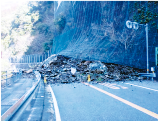
写真20. 平成23年2月26日（土曜日）崩壊全景
