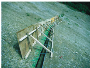
仮設落石防止柵
