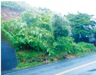
写真1. 6月16日土砂崩れ状況
