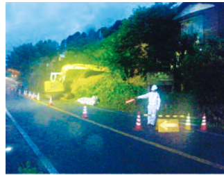
写真2. 土砂除去作業状況
