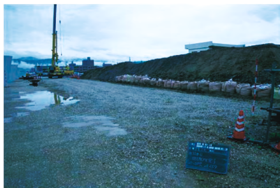
写真12 碎石敷均し完了
