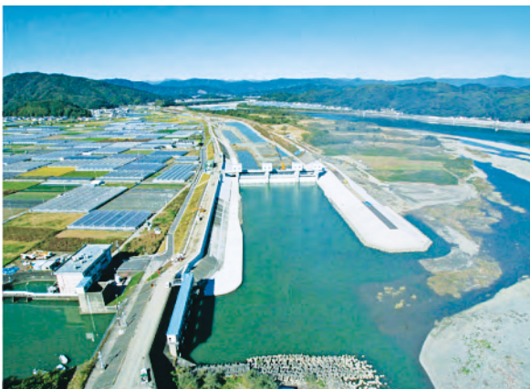
波介川導流路河口から上流を望む (H23.11撮影)
