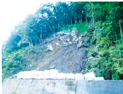
写真17. 作業中における仮の小落石防止処置
