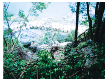
写真11. 上から見た土のう防護壁
