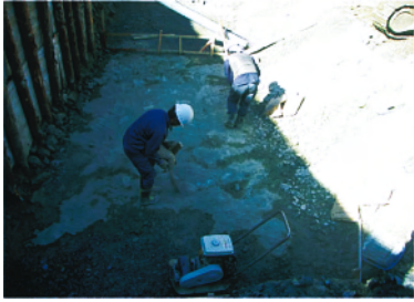
セメント安定処理
