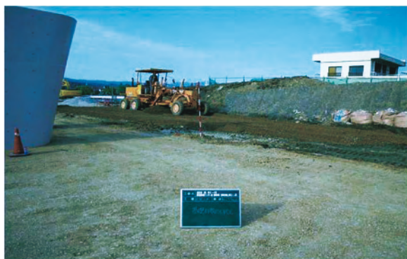
写真11 碎石敷均し状況
