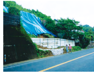
写真3. 仮設対策完成
