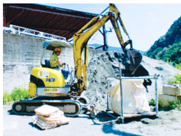
写真9. 土のう作成状況
