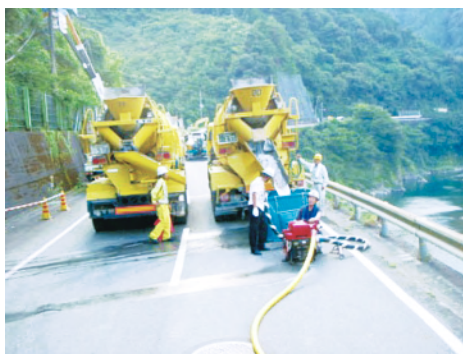
写真12. アジテーター車による給水状況
