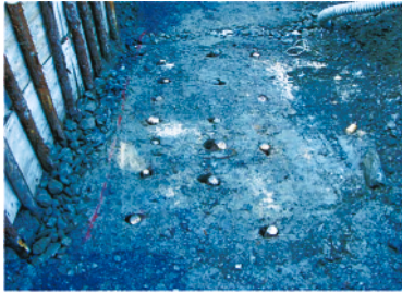
松杭による支持杭
