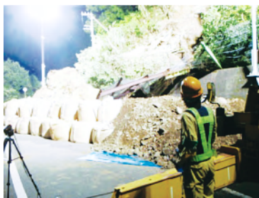
写真10. 土のう防護壁
