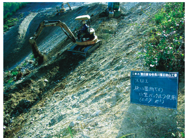
バックホウ ( 0.09\text{m}^3 ) による法切作業
