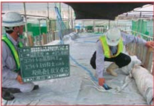
写真一五 パイプクーリングによる温度抑制状況
