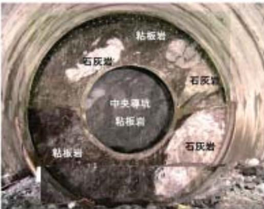
写真-2 切羽状況(粘板岩と石灰岩のメランジェ)
