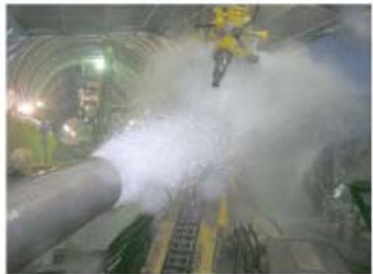
写真-1 湧水状況(2.1MPa, 5 t/分)
