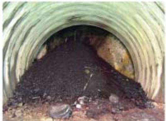
写真-3 TD1,186m本坑切羽崩落状況
