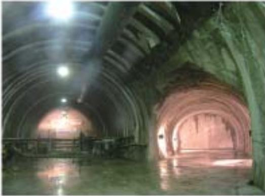
写真-4 迂回注入坑坑口部（右側）
