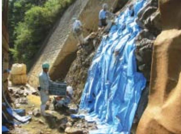
この種の小規模災害復旧工事では、切土工は地山への擦り合わせ程度で納める設計が通常であり、本工事でもオーバーハングを切り取るだけの実施設計でした。しかしそれでは、斜面が安定せず、切り取り作業が完了してラス張りを開始した時点で、斜面に亀裂が入ったのを発見しました。そのまま吹付法枠の施工を強行するのは危険すぎるため、切り直し。結局、都合2度の切り直しをすることとなりました。
