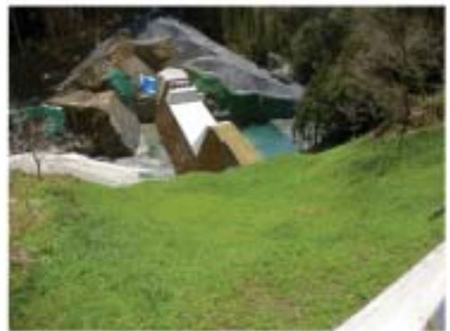
上流側から完成写真
