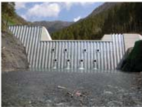
下流側から完成写真
