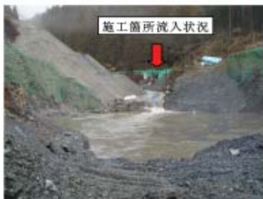
集中豪雨による被害状況
