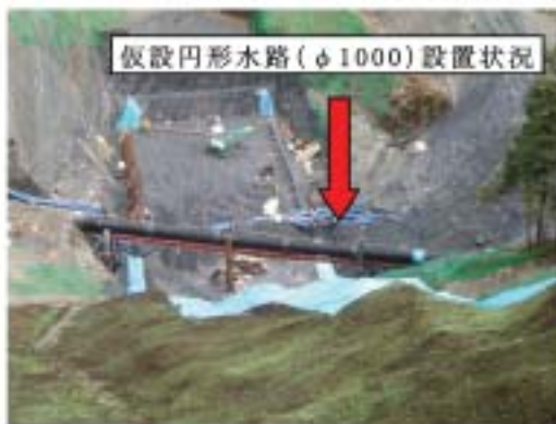
仮設円形水路（φ1000）設置状況
