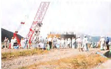
新四万十川橋工事
