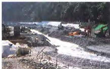
宗呂川河川復旧工事
