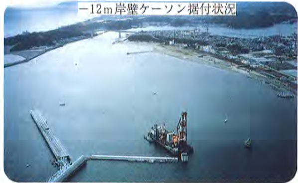
起重機船によるケーソン吊り出し状況
