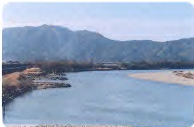
現在も残っている仁淀川八田の水制工
