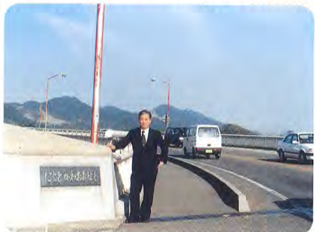
国道 56 号線仁淀川大橋 (土佐市中島)
