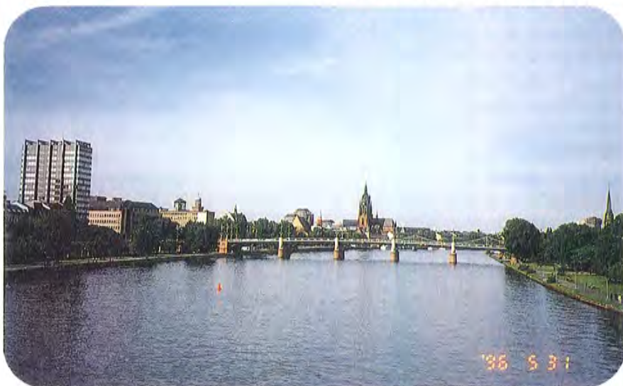
マイン川（フランクフルト市内を流れるライン川の支流）（写1） 左右岸とも高水敷きが非常に広く、巨木が木陰の役割を果たしている
