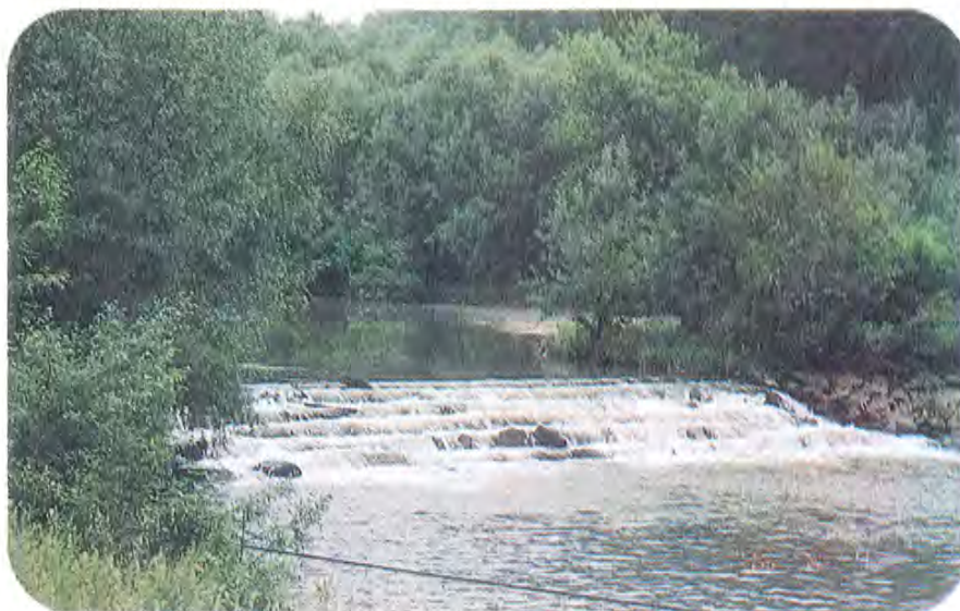
石積みによる階段状の落差工
