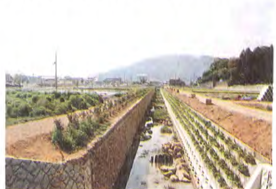
写真-8 完成後5カ月
