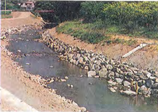
写真-2 完成直後
