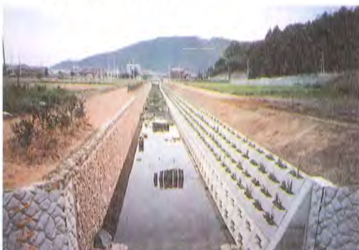
写真-7 完成直後
