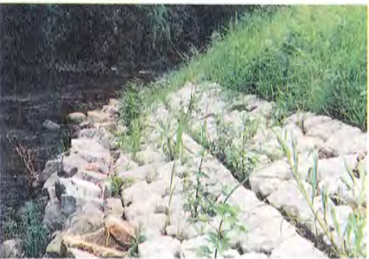
写真-4 張りブロック区間
