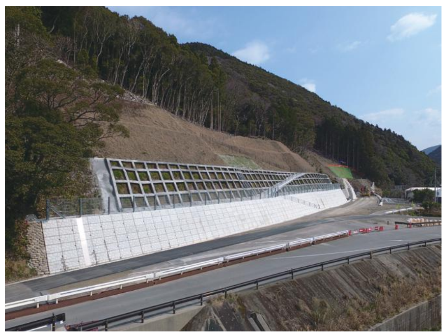
国道493号道路災害関連工事 有限会社 礒部組
