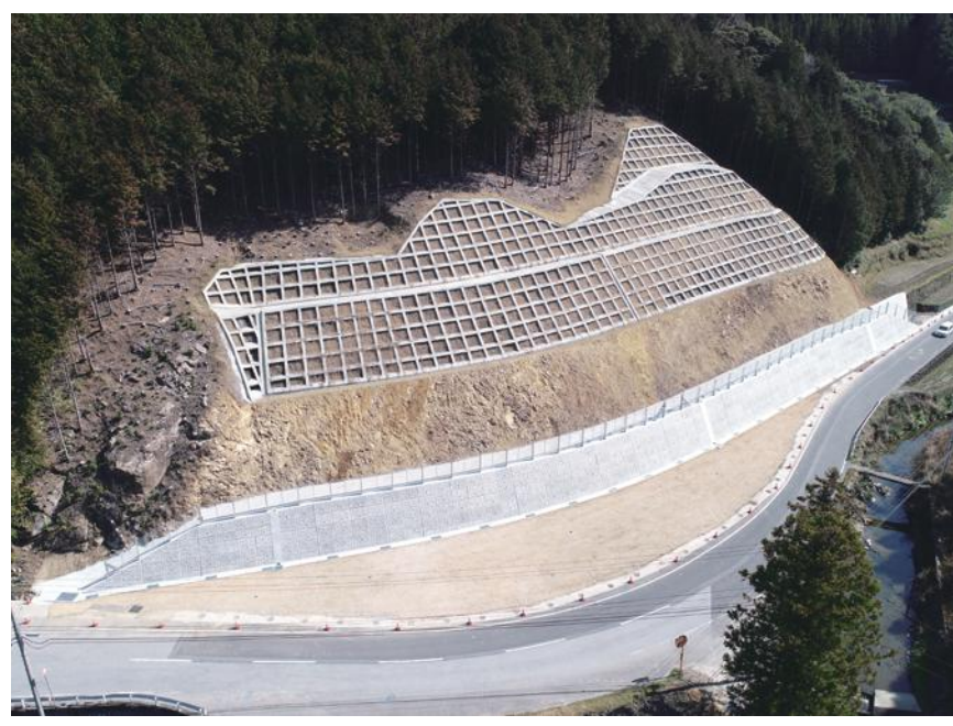
県道龍河洞公園線防災・安全交付金工事 有限会社 武政建設
