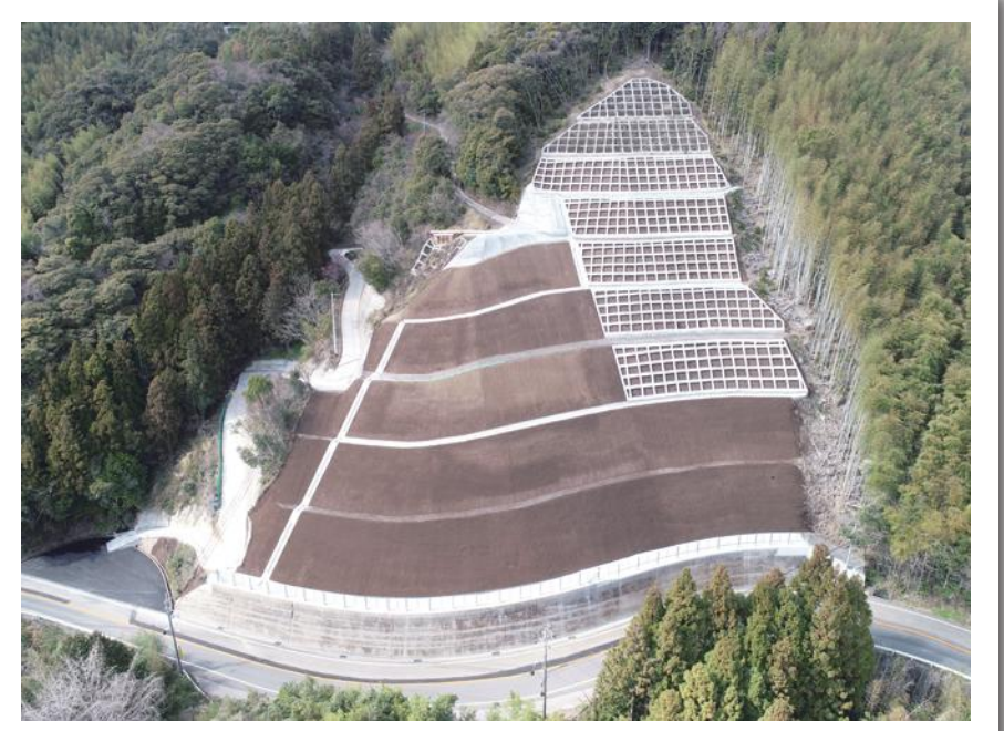
県道高知本山線防災・安全交付金工事 福留開発 株式会社 関西新洋米村 株式会社
