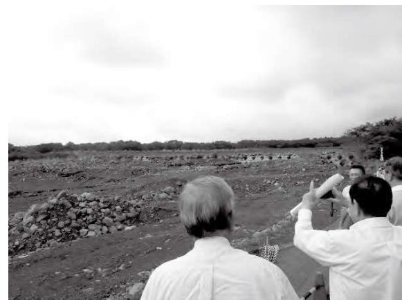
次に鞍骨沢沈砂池を視察しました。ここは、現地発生材を活用したソイルセメントで堰堤や袖部を築き、上流側を掘削することにより堆砂空間を確保するものです。軽量矢板（内側）と化粧ブロック（外側）を型枠代わりにし、内部に現地練したソイルセメントを充填するもので、現地は、堰堤は水通し部を残し完成して、袖部も半分ほどできていました。
