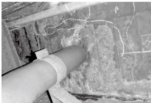
図-1 排水枠部漏水による損傷事例
