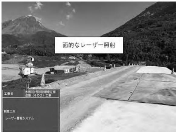
図-5 レーザーセンサーと警報機
